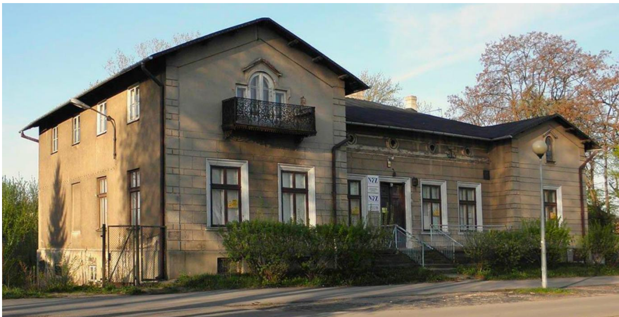
Rysunek 6. Widok budynku objętego projektem – stan aktualny
